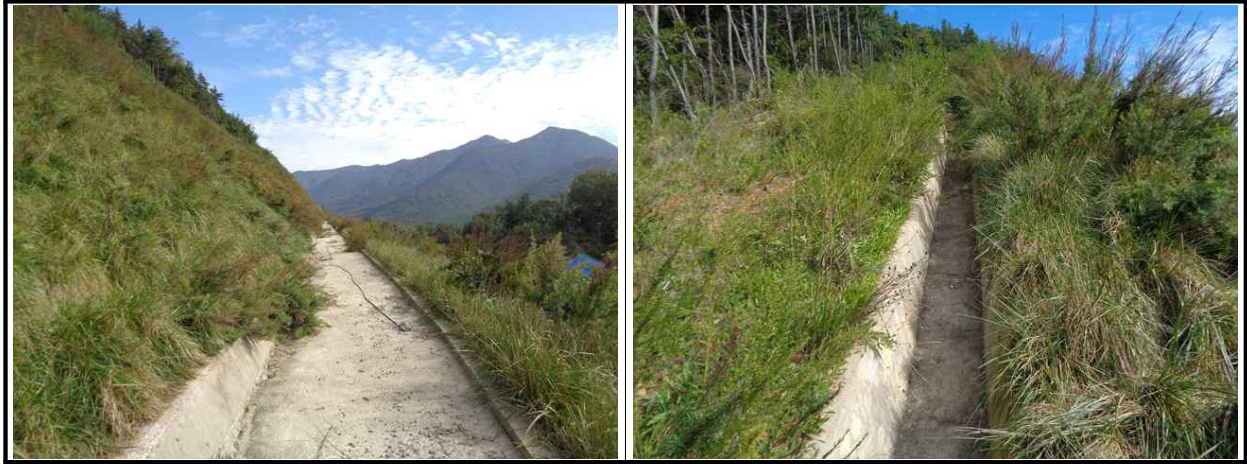
【그림 13.3.3】 배수시설 전경
