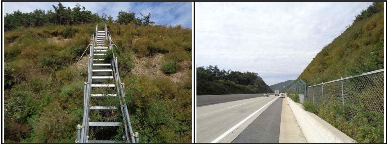
【그림 13.3.4】 보호/보강시설 전경
