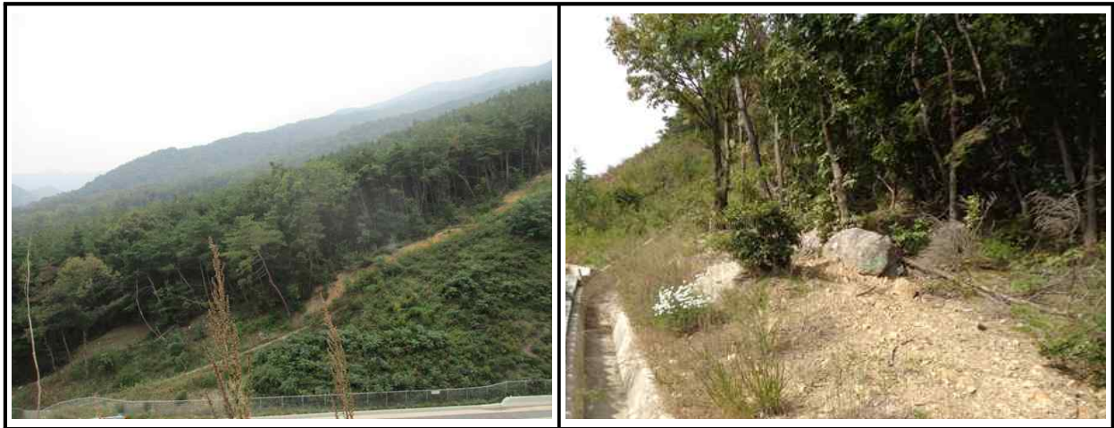
【그림 13.3.1】 상부자연사면 전경
